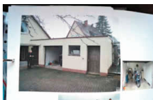
Die Garage vor ihrem Umbau.
